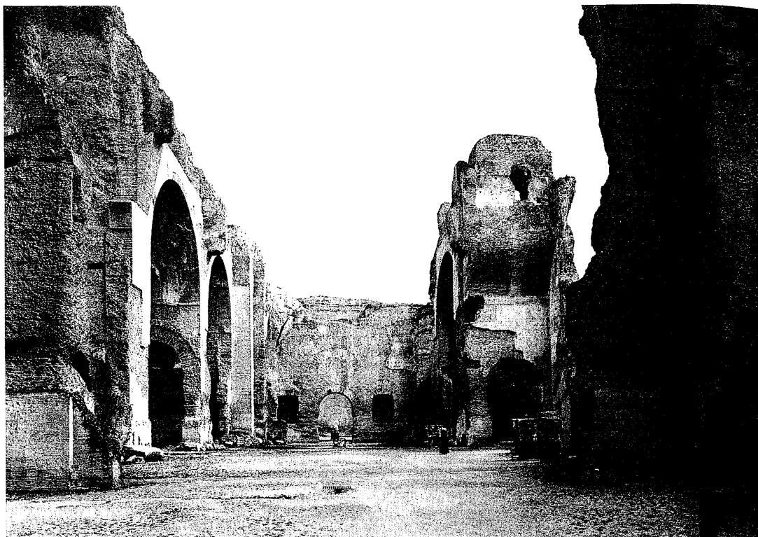
Thermes de Caracalla à Rome, 206-217 après J.-C. Voûtes construites selon la technique de l'« opus cæmenticium » (Alinari-Viollet)
