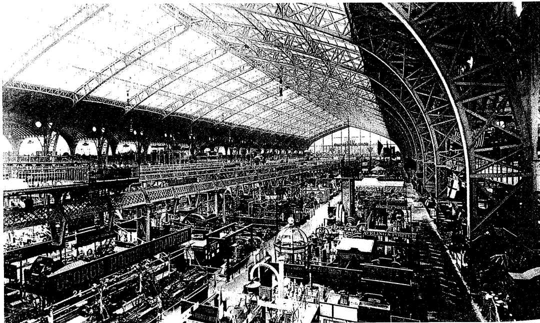
Vue intérieure de la galerie des Machines, œuvre de l'architecte F. Dutert et de l'ingénieur V. Contamin. Exposition universelle de 1889, Paris (collection Viollet)
