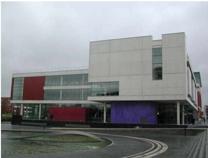
BU de Saint-Quentin (SCD de l'UVSQ). Extérieur (architectes Ripault & Duhart). Photo AM Chaintreau, mars 2005.
