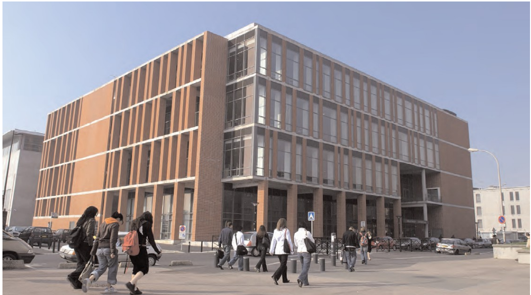
Vue extérieure de la bibliothèque
