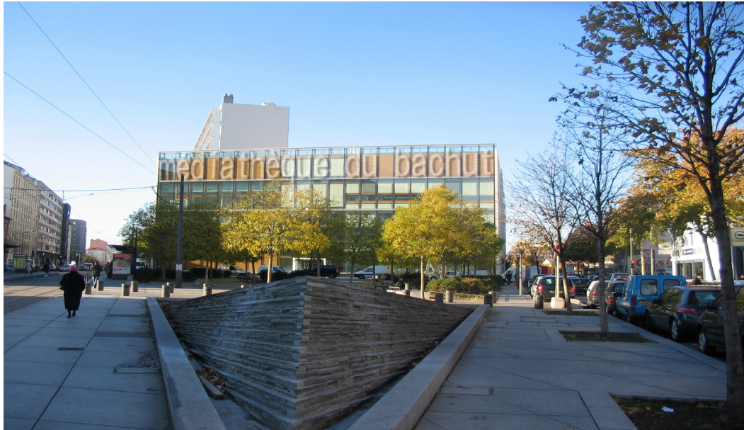
Vue extérieure de la bibliothèque
