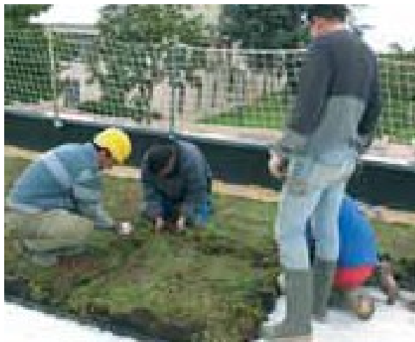
Pose de la toiture végétalisée
