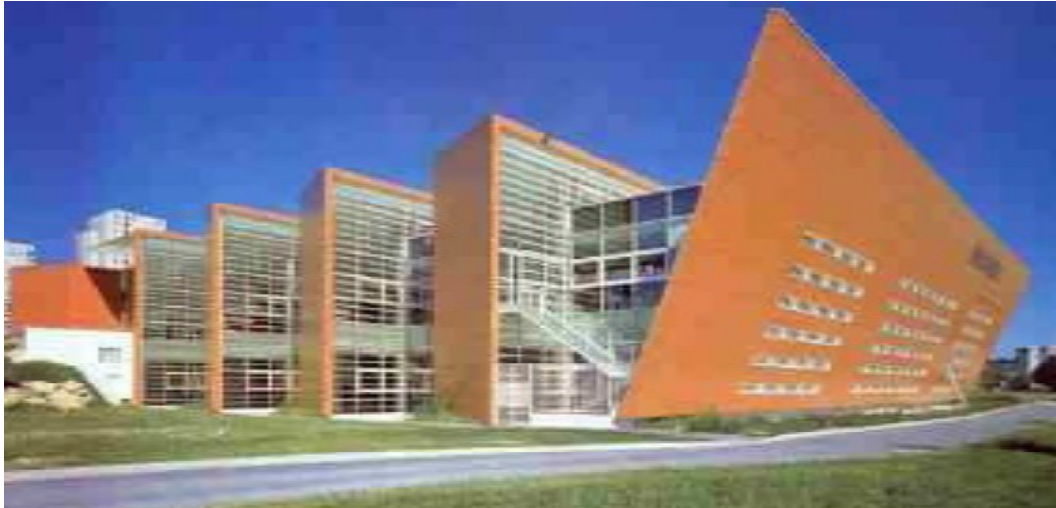
Vue extérieure de la bibliothèque
