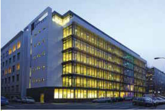
Lyon II. Chevreul. Thierry Van de Wyngaert, architecte.
