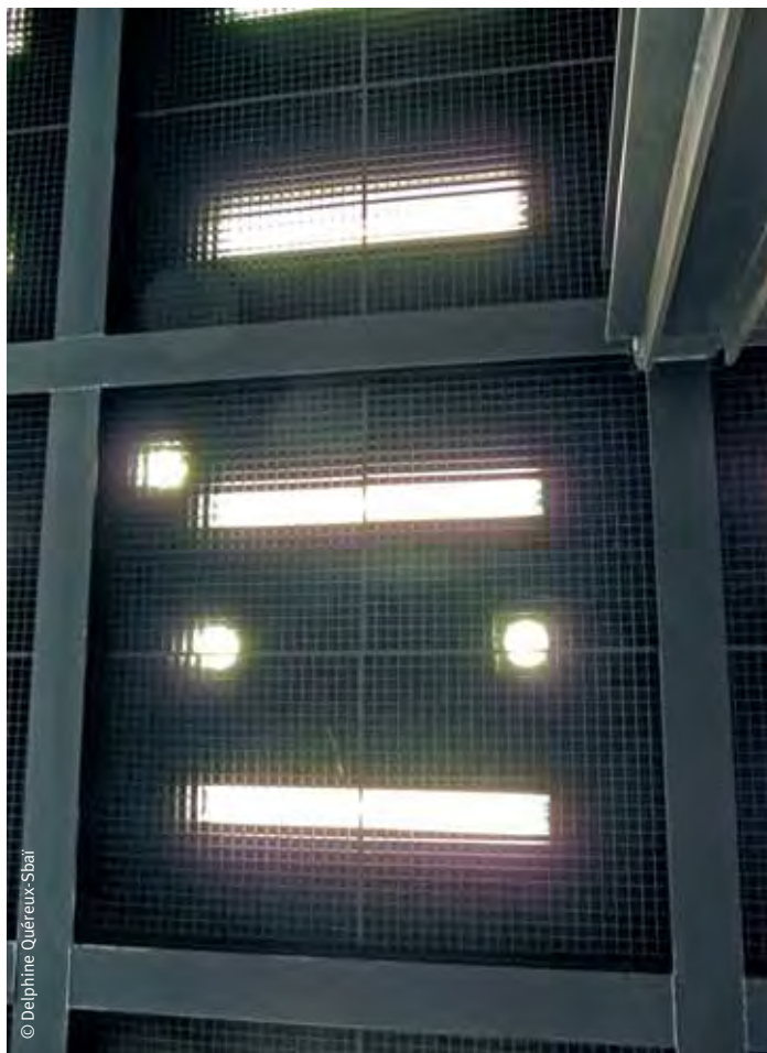
Médiathèque centrale de Reims, à g. : éclairages partiellement dissimulés derrière une résille métallique noire en plafond ; à d. : verrières en façade et résille noire en plafond : deux sources de difficultés.
