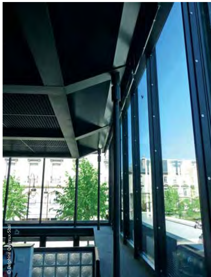
Médiathèque centrale de Reims, à g. : éclairages partiellement dissimulés derrière une résille métallique noire en plafond ; à d. : verrières en façade et résille noire en plafond : deux sources de difficultés.
