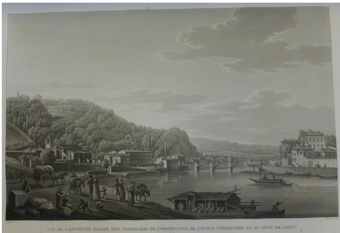
Ill. 12 : Vue de l'ancienne église des Cordeliers de l'Observance, de l'école vétérinaire et du pont de Serin
