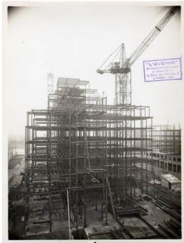
**Figure 73 : Gratte-Ciel : ossature métallique et grue**
