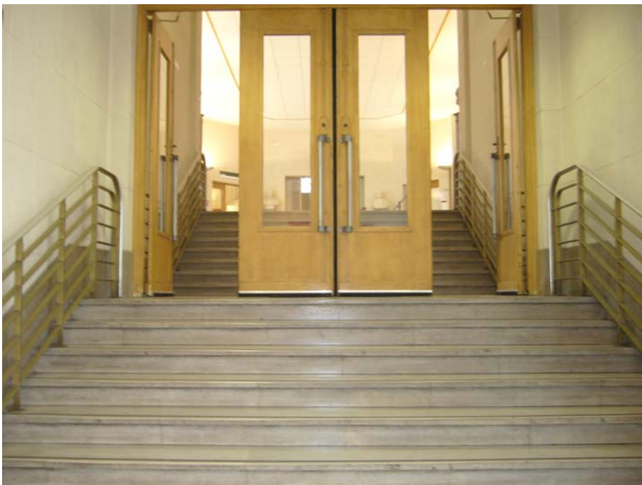
Escaliers desservant le hall d'accueil et la salle de lecture
