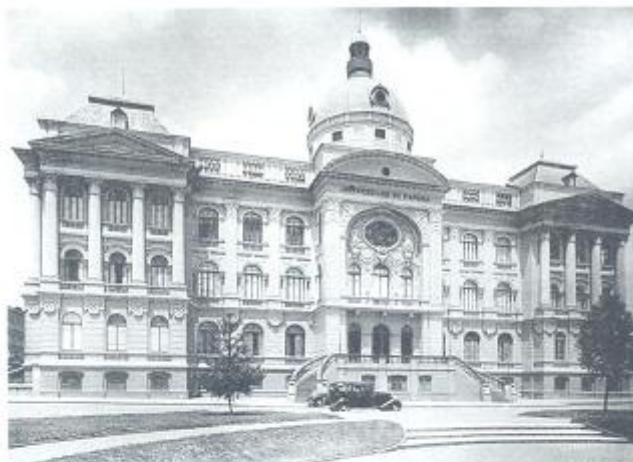
O edifício já com seus primeiros acréscimos laterais. Fonte: Arquivo dna, Flora.
