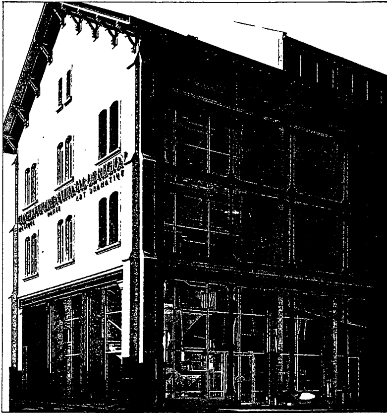
Spécimen de l'architecture industrielle du XIX e siècle, l'ancienne manufacture des tabacs...
