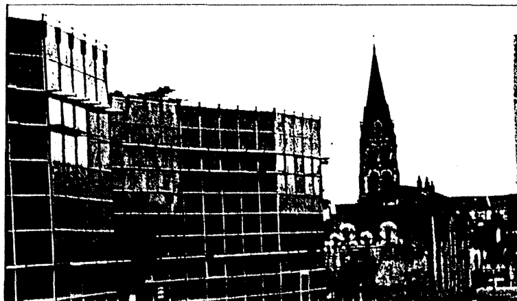
C'est dans les locaux de la médiathèque de Saint-Genis-Laval qu'a eu lieu le 3 février la présentation de la charte de partenariat. Ouverts au public en mai 1990, ses 1 500 m 2 ont coûté au total 16 MF subventionnés à 30 % par le conseil général, l'Etat et le conseil régional.
