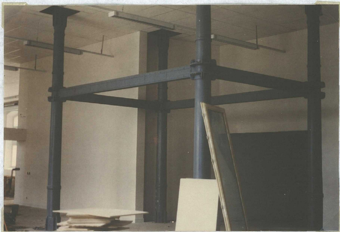
Photo n° 15 : Manufacture : la B.U. en chantier : la future salle de prêt (juin 1993)
