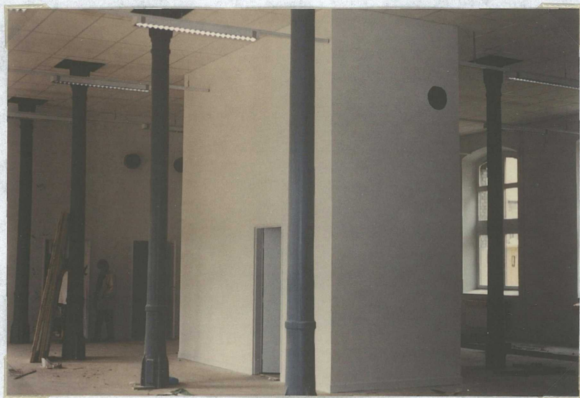
Photo n° 16 : Manufacture : la B.U. en chantier : la future salle de gestion (juin 1993)
