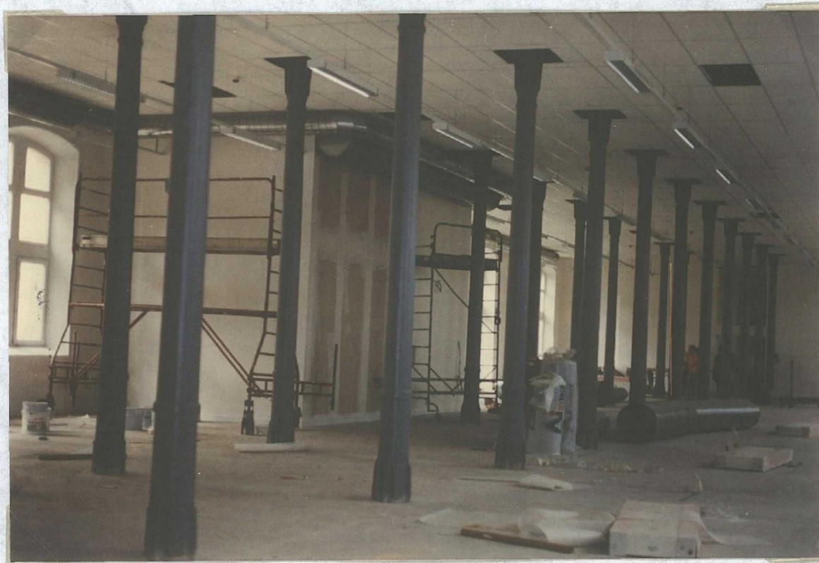
Photo n° 14 : Manufacture : la B.U. en chantier : la future salle de droit (juin 1993)
