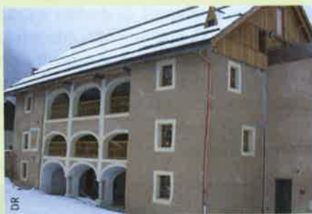
Maison du Parc à Arvieux.
