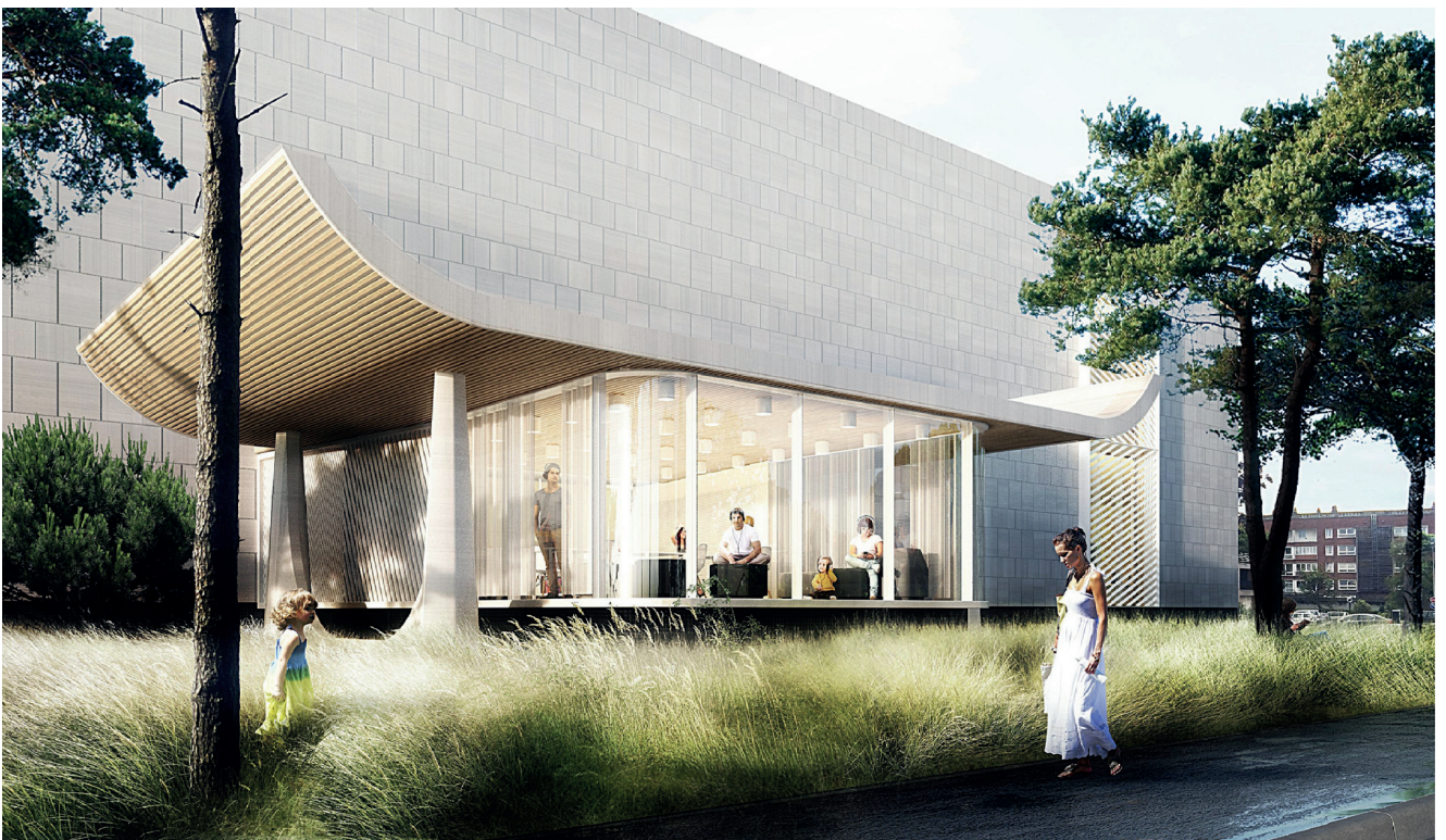
PROJET DE RESTRUCTURATION DE L'ANCIEN MUSEE DES BEAUX-ARTS EN BIBLIOTHEQUE VILLE DE DUNKERQUE
