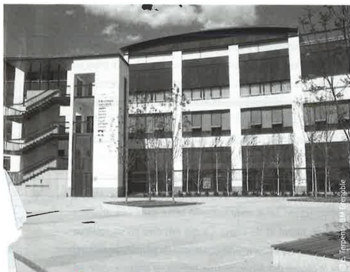
La bibliothèque internationale de Grenoble s'est construite autour d'un fonds multilingue.
