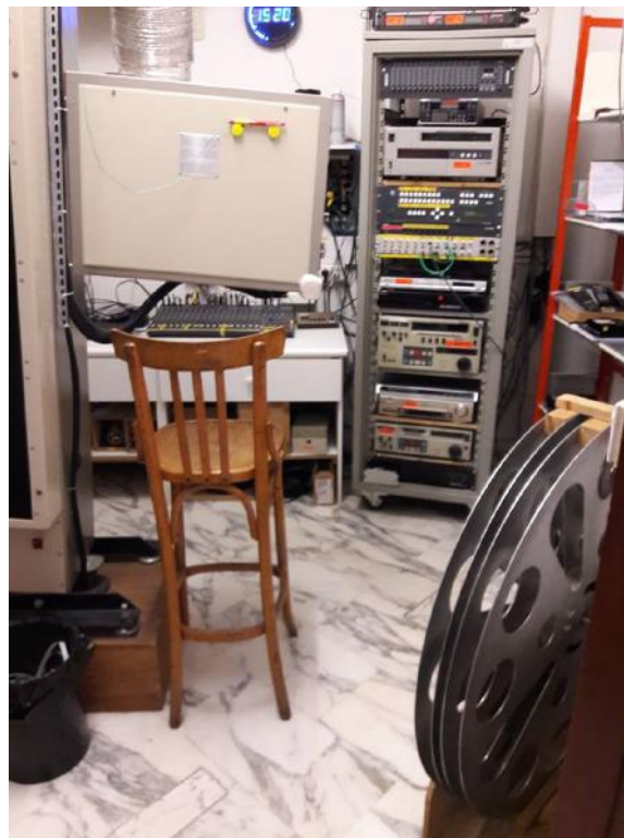
Figure 25 : Cabine de projection (source : photographie personnelle)
