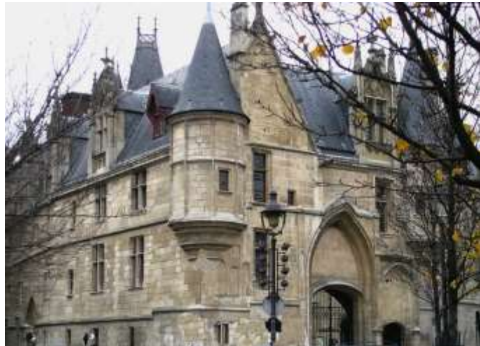
Figure 10 – Vue de l'ancien hôtel des archevêques de Sens
