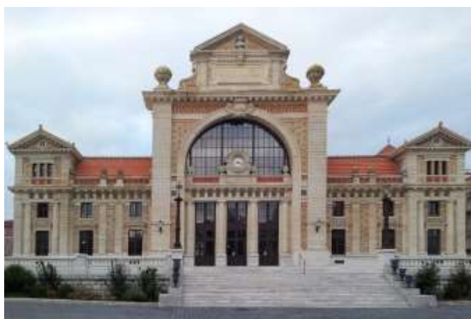
Figure 11 - Entrée du bâtiment de l'ancienne gare du Sud de Nice
