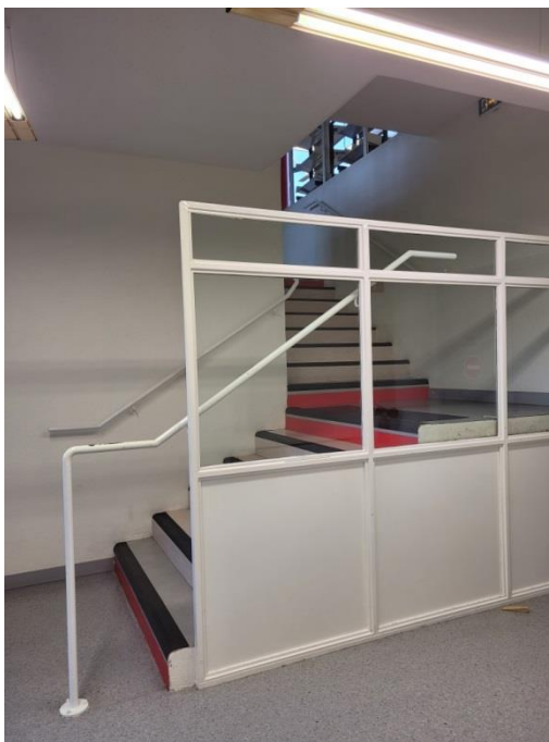
Document 8 : Escalier qui permet de descendre au niveau -1 de l'Espace Patrimoine à la médiathèque Vailland.
