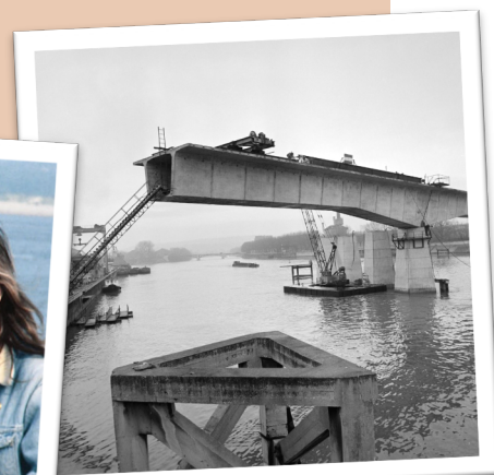
Le périphérique parisien en chantier, 1967 crédit : Georges Hernad
