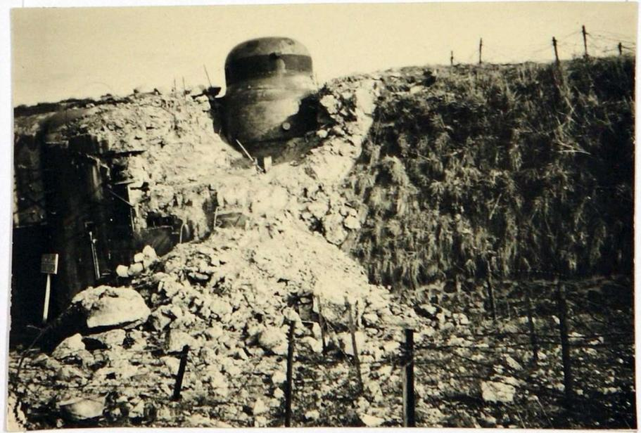
**Figure 69• Un cuirassement fixe type « cloche » qui fut la cible de tirs nourris. 5 x 8 cm (Source : AD17, 62 Fi 16)**
