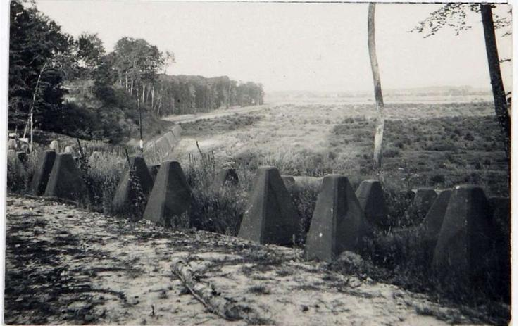
**Figure 5• Barrage anti-véhicules le long de la ligne Siegfried. Frontière allemande, 1940. 5 x 8 cm (Source : AD17, n°62 Fi 24)**
