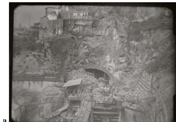
Illustration 109 : Travaux sur le tunnel ferroviaire reliant Campanhã à São Bento, PT/CPF/ATF/B-A/001/0004/000143 - b. Construction d'une canalisation d'eau PT/CPF/ATF/B-A/001/0004/000135) et c. Chantier de grande envergure, PT/CPF/ATF/B-A/001/0004/000134.
