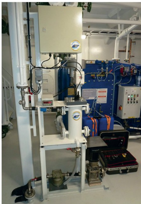
Thermosalinographe à bord d'un navire © D. Diverrès
