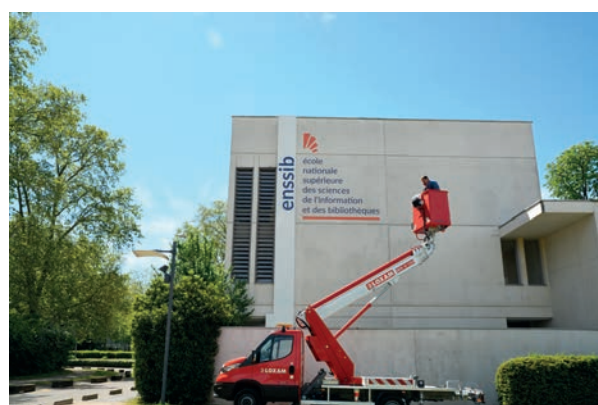
Installation d'une nouvelle signalétique
